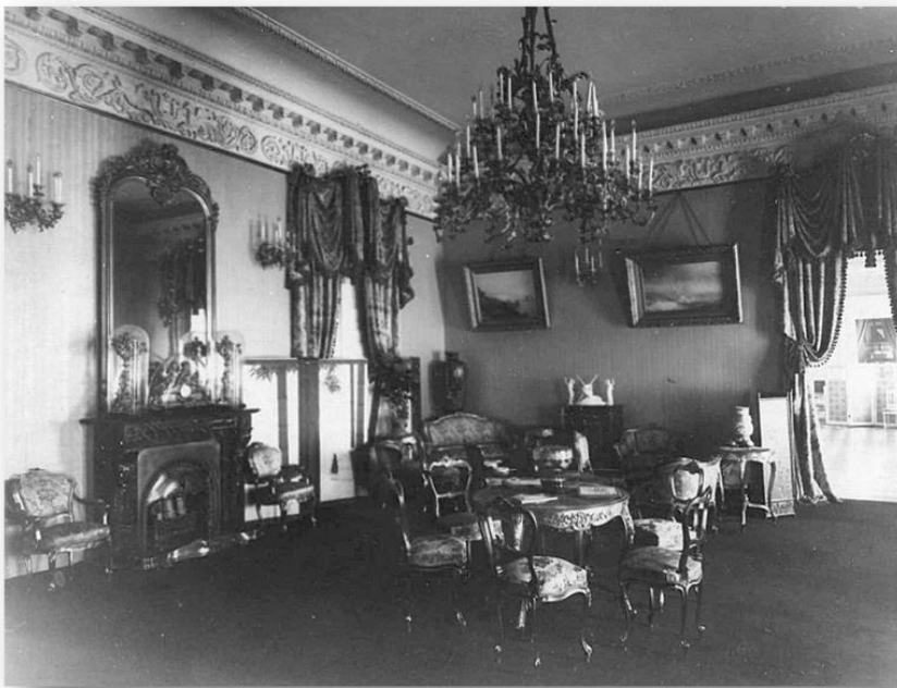
”Palatul Cantemir”, vedere din interior
